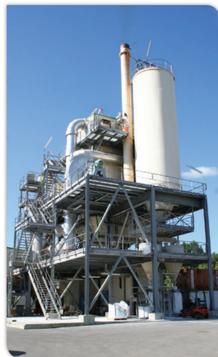
Unité de vitrification de déchets d'amiante (Morcenx-Landes)
